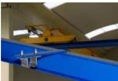
PLETINAS SOLDADAS A LA VIGA
